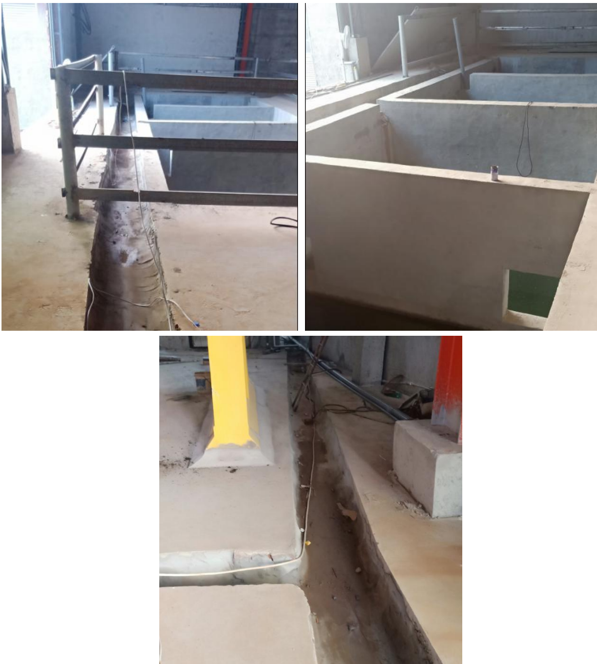
图 3-1 废水经沉淀池沉淀后循环使用
