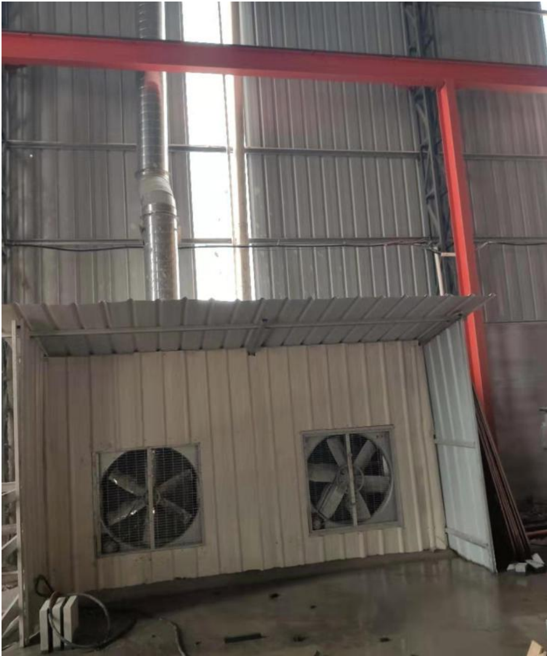
湿法除尘设施处理后+集气罩+15m 高排气筒排放
