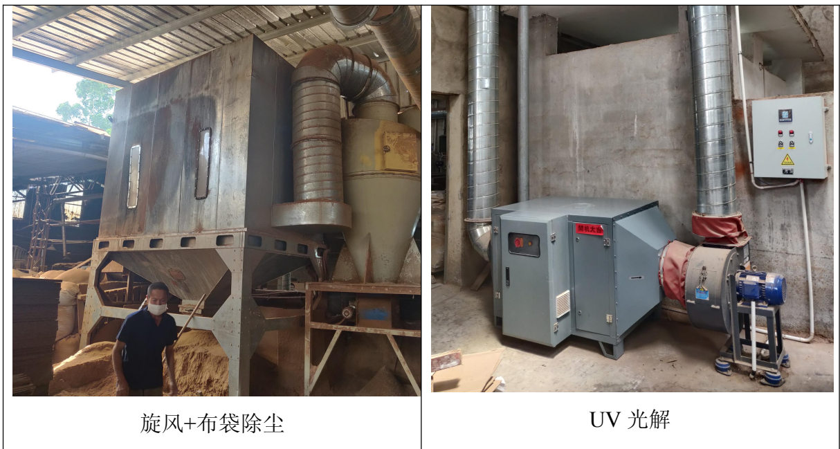
图 3-1 废气处理设施照片
