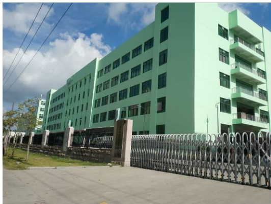
项目外部现状（3#车间 1层北部）
