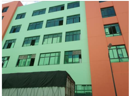
南侧 青蛙王子（中国）日化有限公司厂房
