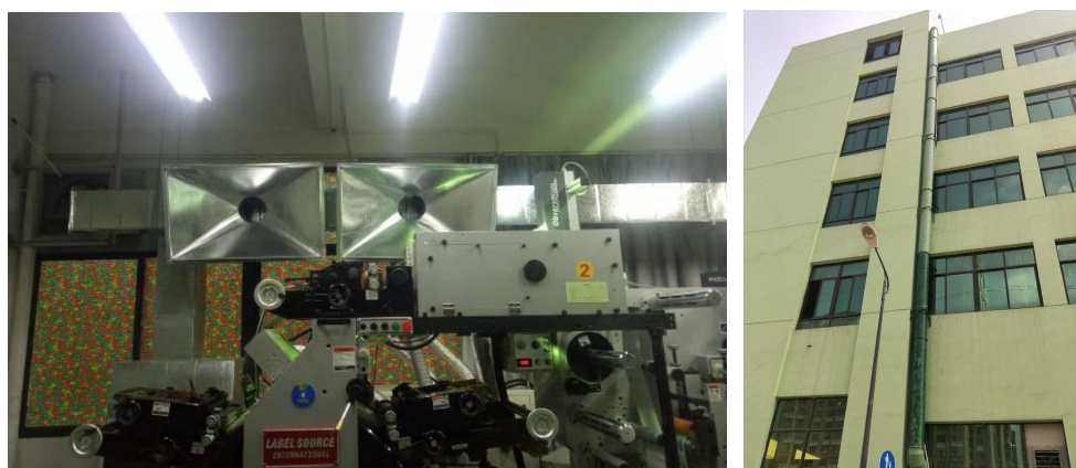
图 8-4 项目废气治理设施照片 (集气罩、UV 光解+活性炭吸附设施、22m 排气筒)
