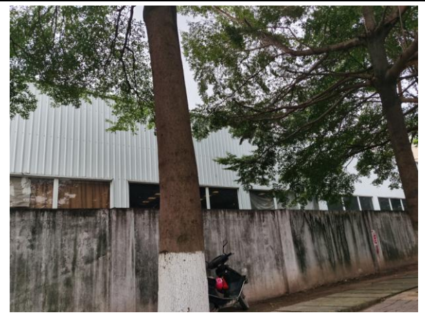
西侧现状图 漳州正众汽车有限公司
