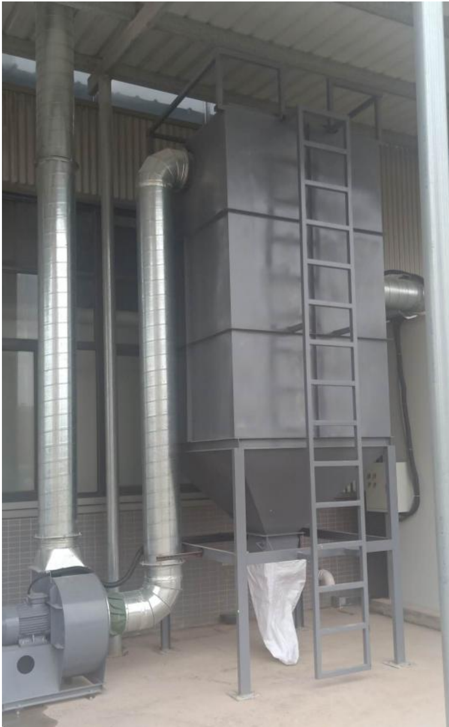
布袋除尘器后通过 15m 高排气筒排放
