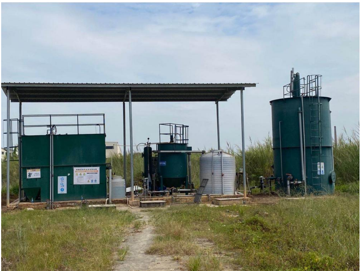
污水处理设施
