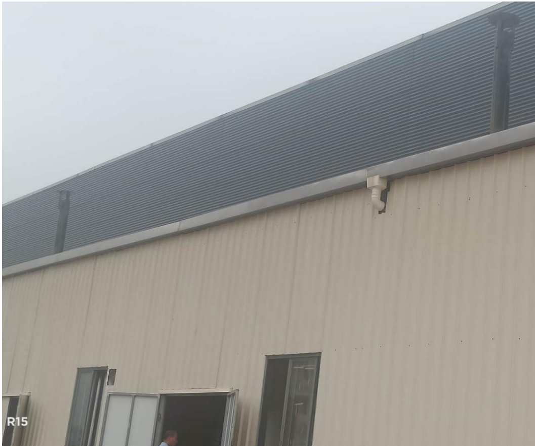
天然气锅炉废气通过高度均为 8m 烟囱排放
