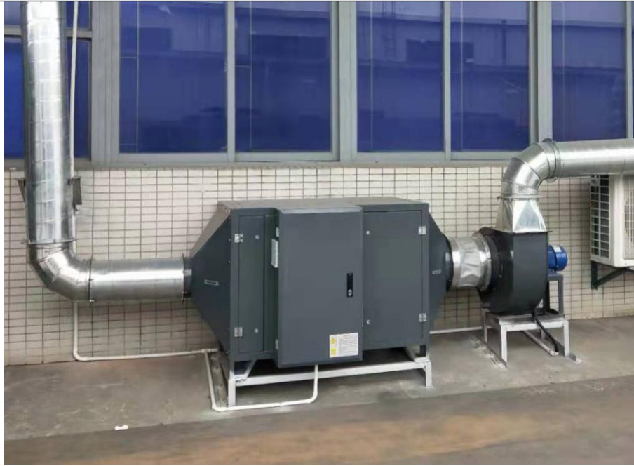
图 3-1 有机废气-UV 光解+活性炭吸附装置
