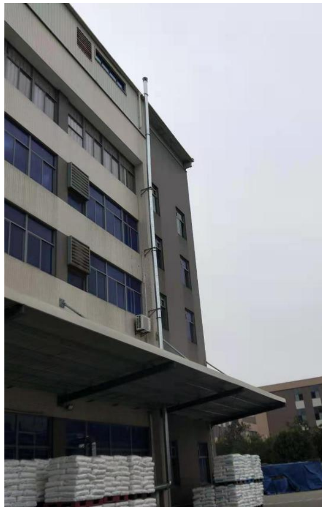
图 3-2 项目废气排气筒
