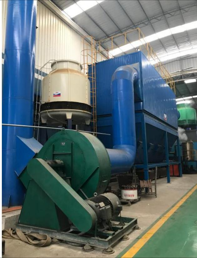
项目采用“全封闭固定罩+脉冲喷吹袋式除尘器”处理工艺处理锌烟，全封闭固定罩集气效率为 95%，脉冲喷吹袋式除尘器对锌尘的净化率为 99%，废气处理后通过 1 根 15m 高排气筒排放（排气筒编号 P4）。废气处理设施照片如图所示：
