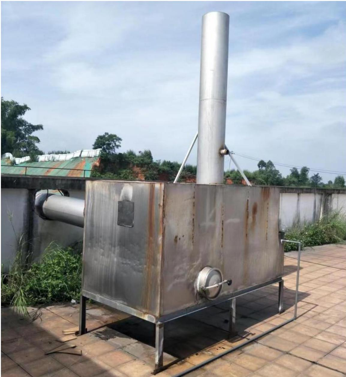
图 3-2 废气处理设施（锅炉废气经水膜除尘处理后通过风机引至 22m 烟囱高空排放）
