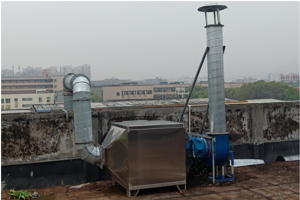
印刷废气处理设施（UV 光解吸附装置）
